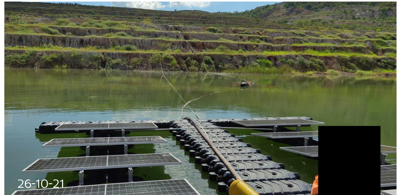
ติดตั้งระบบสูบน้ำ Solar Floating
